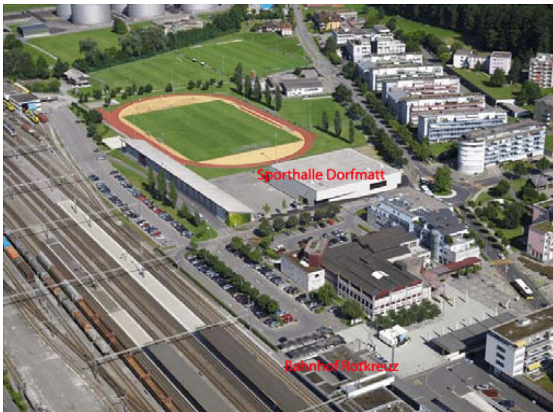
Die Sporthalle Dorfmann befindet sich auf der Dorfseite/Südseite des Bahnhofs Rotkreuz
